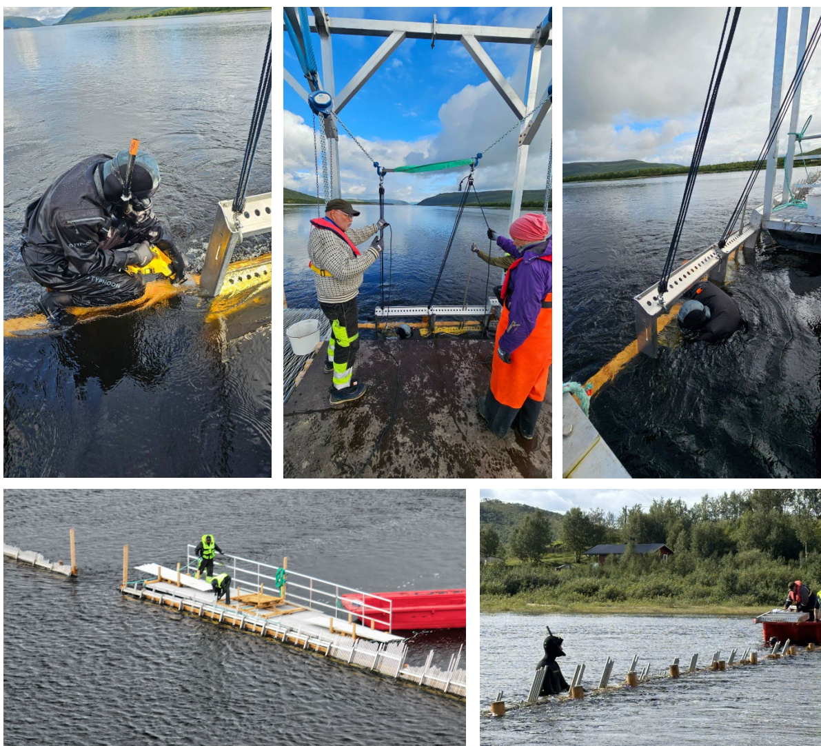
Figur 4.7. Demontering av sperregjerdet og transport inn til land.
