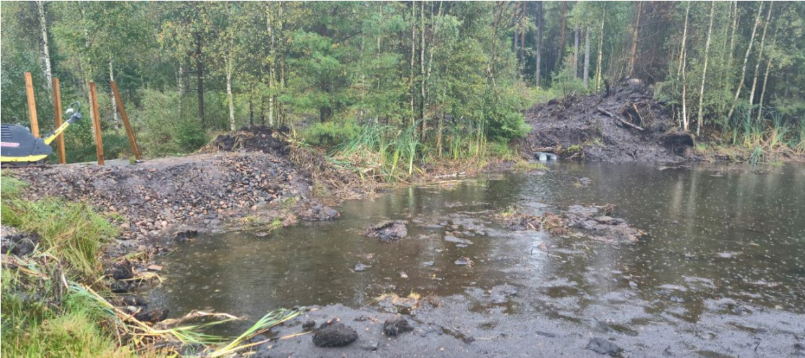
VFigur 4. Utløpet i dam C1, etter midlertidig ombygging 17. september. I vollen til høyre ses to rør som ble demontert ved behandlingsstart av dam C1, dagen etter (18. september). Foto: Øystein Kielland/Veterinærinstituttet
