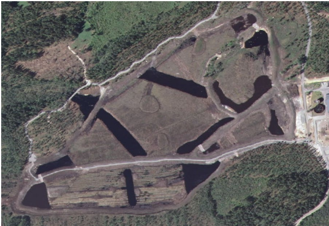
Figur 5. Flybilde av Rastadammene, under konstruksjonen i 2006.
