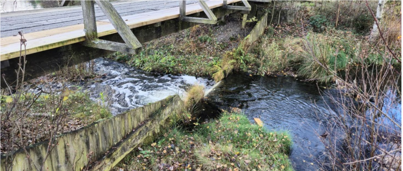
VFigur 7. Utløpet fra dam B1 ned til dam C1. Her var det under normal situasjon et 50 cm høyt vandringshinder. Ved behandlingstidspunktet var denne avstanden økt til omtrent 80 cm. Foto: Øystein Kielland/Veterinærinstituttet
