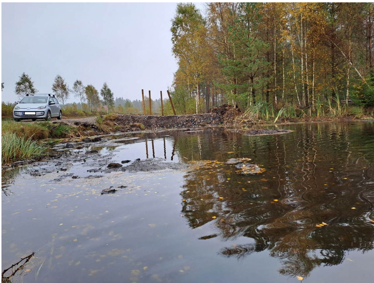
VFigur 9. Bilde tatt ved utløpet av dam C1 8. Oktober 2025. På dette tidspunktet ble vannstigning siden behandling estimert til omtrent 30 cm, og at man hadde mindre enn en meter til det rant over ved veggen til venstre i bildet. Foto: Stina Kullingsjö/ Gislaveds kommun
