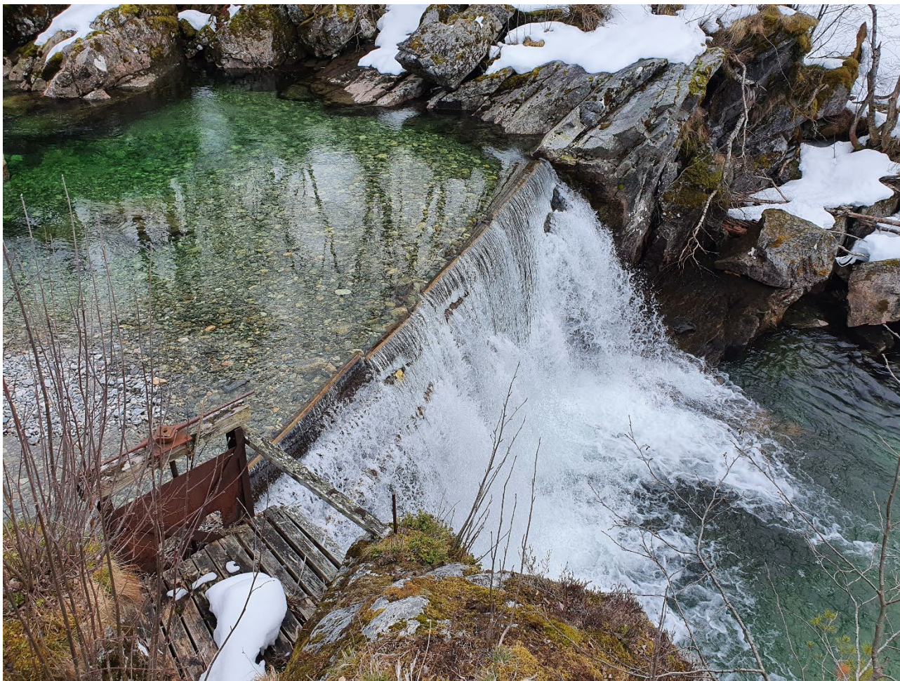
Figur 4.. Vandringsbarrieren i Fallfossen i Usma ble forsterket i 2017. Bildet er fra april 2021. Foto: Helge Bardal, Veterinærinstituttet.
