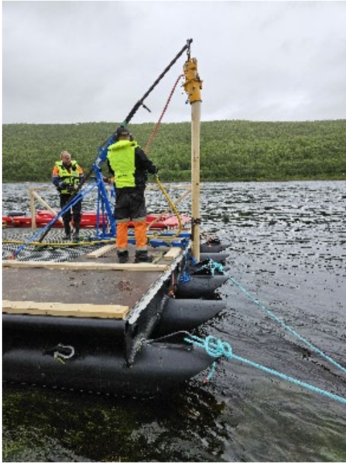
Figur 3: Bildet viser den trykkluftdrevne stolpebankeren med løfteanordningen («elefantjekken») montert på arbeidsflåta.
