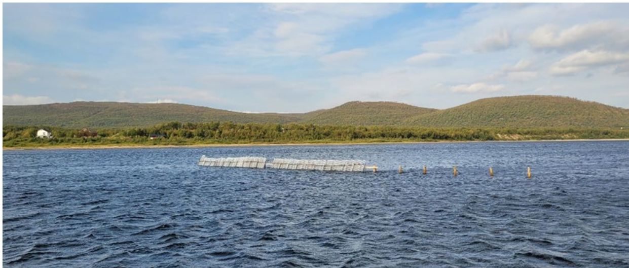
Figur 8: Testrigg ved Seida ferdig montert. Stolpene uten aluminiumsrister ble slått ned som anlegg og fortøyningspunkter for arbeidsflåte.
