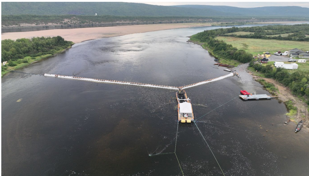
Figur 4. Oversiktsbilde (sett fra oppstrøms fella i retning nedover elva) over ledegjerde, sperregjerde og flåte i det østre løpet av Tanaelva ved Seidaholmen. I venstre bildekant sees ledegjerdet som en forlengelse av spilegjerdet. Litt til høyre for dette sees at to ristsegment er åpnet (midlertidig) for å tillate oppvandring av fisk. Fotograf: Joachim Henriksen.
