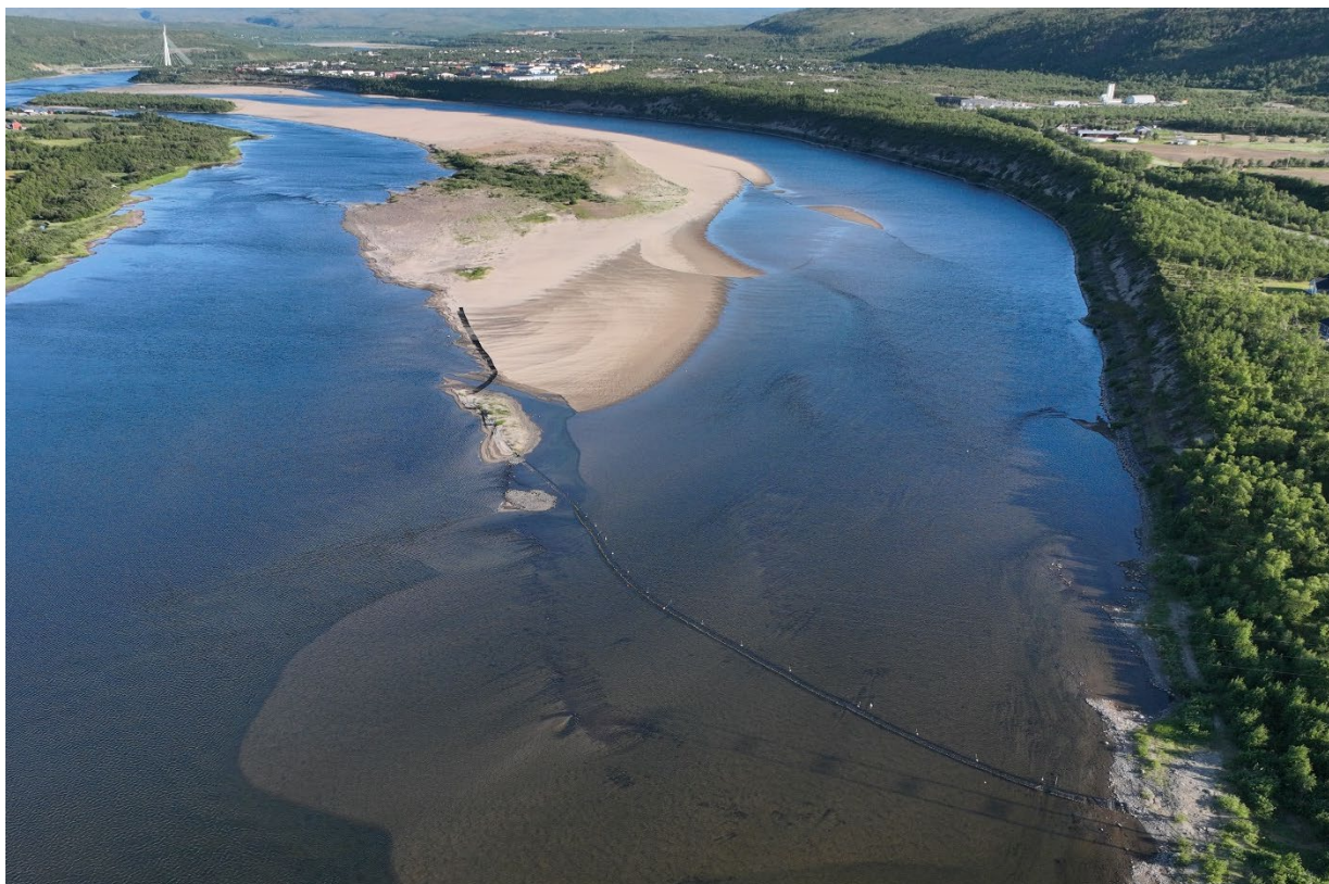
Figur 1. Oversiktsbilde (sett nedenfra og oppover elva) av ledegjerdet i det vestre løpet i Tanaelva forbi Seidaholmen. Fotograf: Joachim Henriksen.
