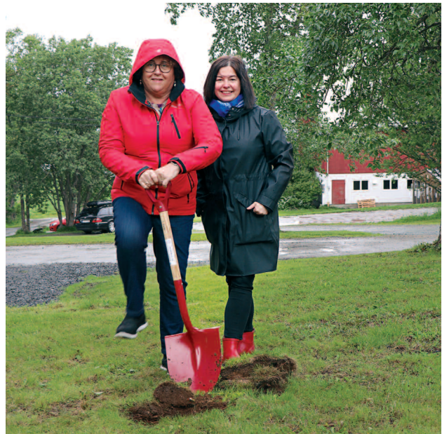
Landbruks- og matminister Olaug Bollestad tar første spadetak på Holt utenfor Tromsø der Veterinærinstituttet får nytt bygg med tilhørende obduksjonssal. Ved sin side har hun Irene Dahl fra Troms og Finnmark Venstre. Foto: Kaja Schill Godager, Landbruks- og matdepartementet.
