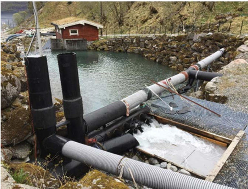
Figur 17. Oppmuret basseng ved vanninntak fra elv
