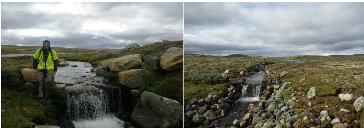
Figur 10. Sperre 1 og sperre 2 ved Stigstuv.
