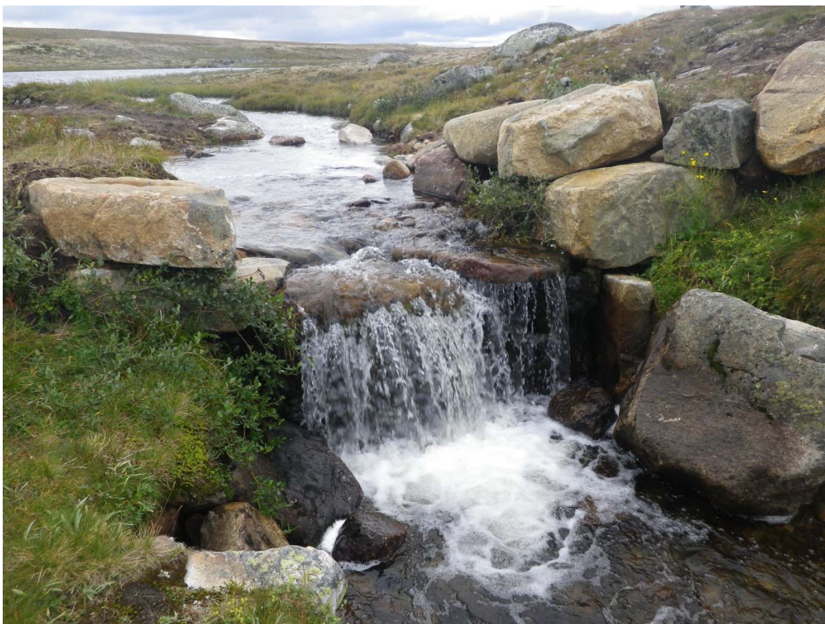
Figur 7. Eksempel på fiskesperre på Hardangervidda bygget av naturlige materialer fra stedet.
