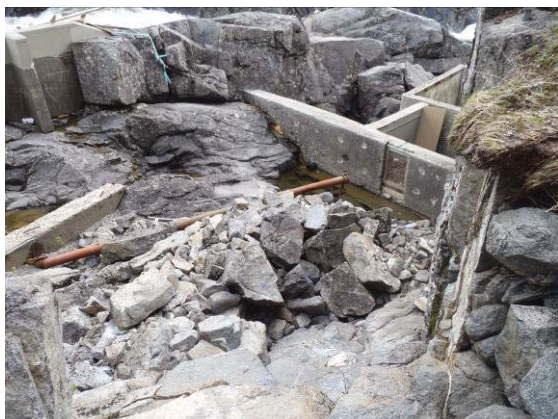
Figur 3: Forsmoforsen under flom mai 2010 (t.v.), og Steinskred i trappa som følge av flommen (t.h.)
