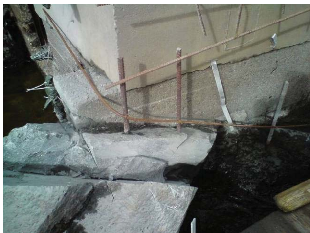
Figur 3: Ny skjæring i fjell for fundamentering av nedre del av trapp
