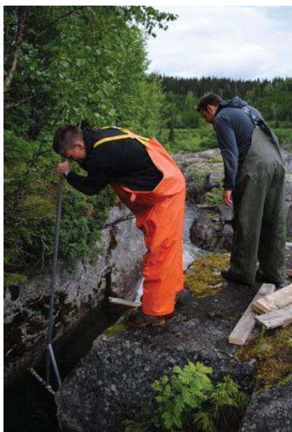
Figur 7: Fjerning av ødelagt terskel på Laksfors, Vefsna
