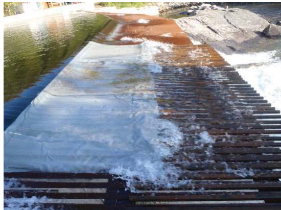
Figur 6: Forskaling av flomvern (t.v.) og rørforlenging og duk på overhoppvern (t.h.)
