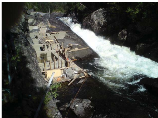
Figur 2: Trappa i Forsmoforsen under utbedring 2010
