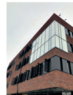
Fasadebilde fra det nye Veterinærbygget på Ås sett fra Veterinærinstituttets del. For tiden pågår bygging og innredning av blant annet kontorer og laboratorier. Foto: Eva Kvandal, Statsbygg
