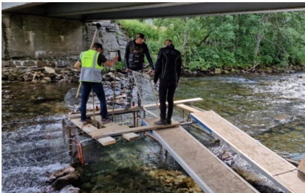
Figur 3.9. Det ble brukt stilasplatt for tilkomst til fella. Foto: Mårelva grunneierforening.
