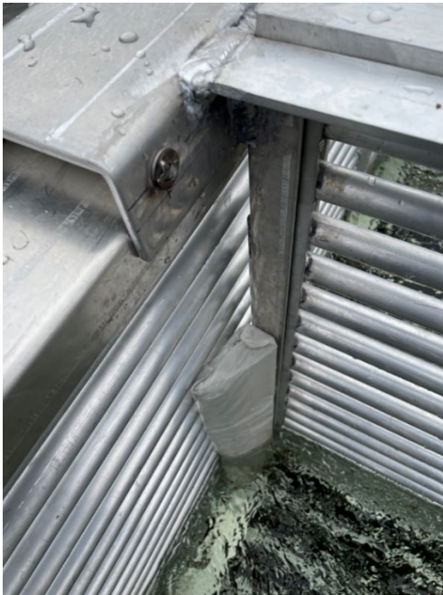
Figur 8.8. Polstring av kant for å unngå snuteskader i buret i Kongsfjordelva. Foto: Eirik Frøiland
