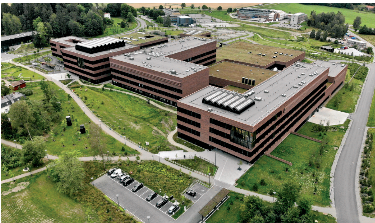
Gjennom 2022 har det vært nedlagt mye arbeid i å stabilisere og optimalisere all virksomhet knyttet til nye fasiliteter. Dette inngår i driftsoptimaliseringsarbeidet som også vil kreve ressurser og oppmerksomhet i de nærmeste årene. Foto: Shane Colvin
