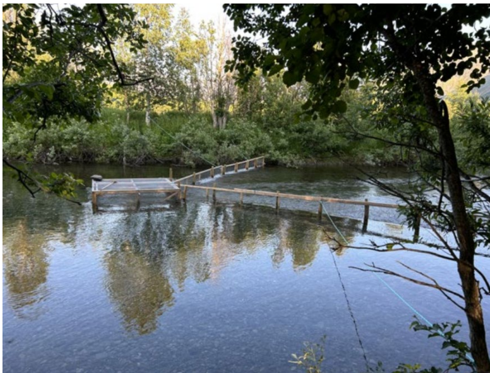
Figur 3.3. Ferdig montert nettingfelle og ledegjerde i Røyeelva. Foto: Reisa Elvelag.
