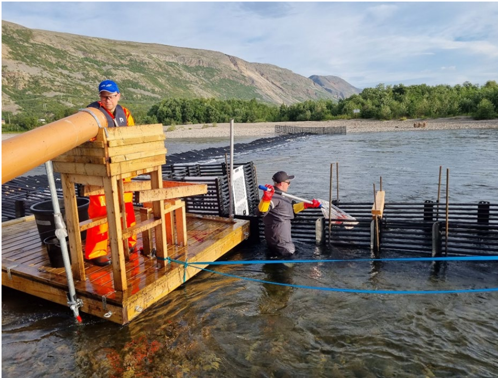
Figur 7.6. I Lakselva ble pukkellaksen avlivet på en flytebrygge ved siden av fangstburet. Brygga ble stabilisert ved hjelp av fire klemhylser som igjen ble festet i fire stålrør banket ned i elvebunnen. Det ble også konstruert et ekstra hvilebur i forkant. Foto: Egil Liberg.
