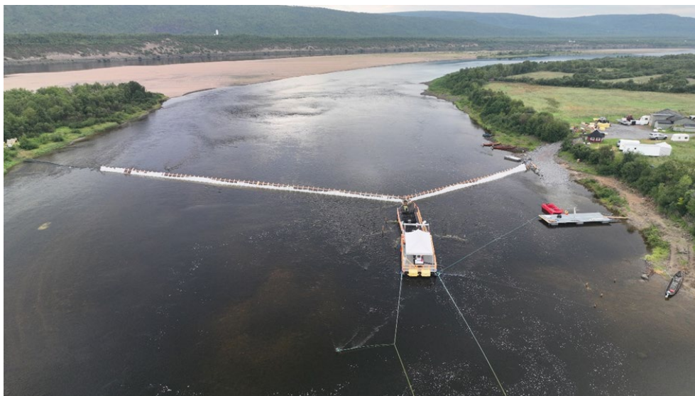
Figur 5.2. Oversiktsbilde (sett fra oppstrøms fella i retning nedover elva) over ledegjerde, sperregjerde og slakteflåte i det østre løpet av Tanaelva ved Seidaholmen. I venstre bildekant sees ledegjerdet som en forlengelse av spilegjerdet. Litt til høyre for dette sees at to ristsegment er åpnet (midlertidig) for å tillate oppvandring av fisk. Fotograf: Joachim Henriksen.
